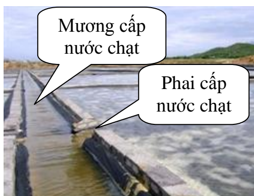
Hình 1.13: Mương cấp nước chạt, phai cấp nước chạt cho ô kết tinh muối
