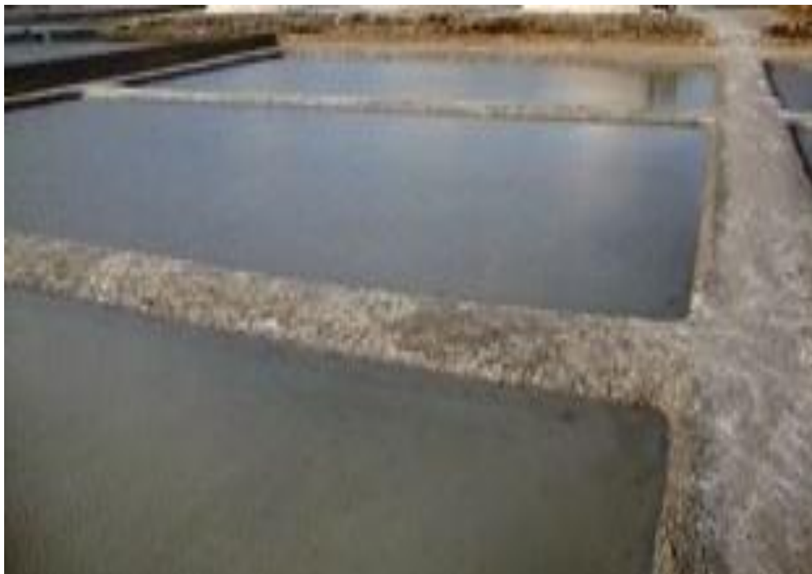
Hình 3.3: Sau khi kiểm tra và tu sửa ô kết tinh mới thực hiện quá trình kết tinh muối
