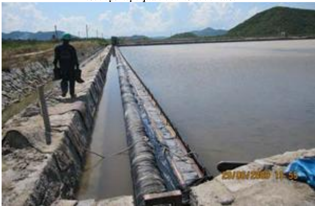
Hình 3.4: Sau khi kiểm tra và tu sửa ô kết tinh mới thực hiện quá trình kết tinh muối
