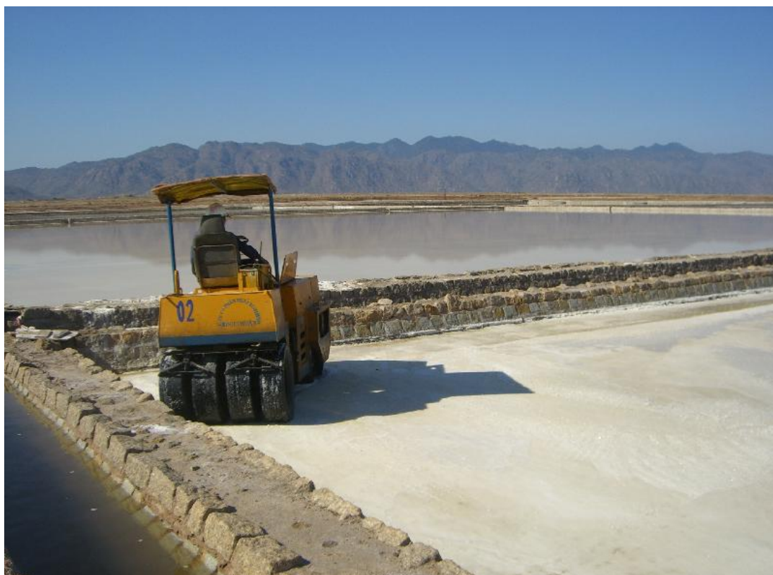
Hình 1.12: Lăn ép ô làm cho khe rỗng giữa các hạt đất thu hẹp lại
