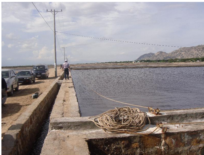
Hình 3.7: Chuyển nước chạt từ khu dự trữ sang khu kết tinh muối
