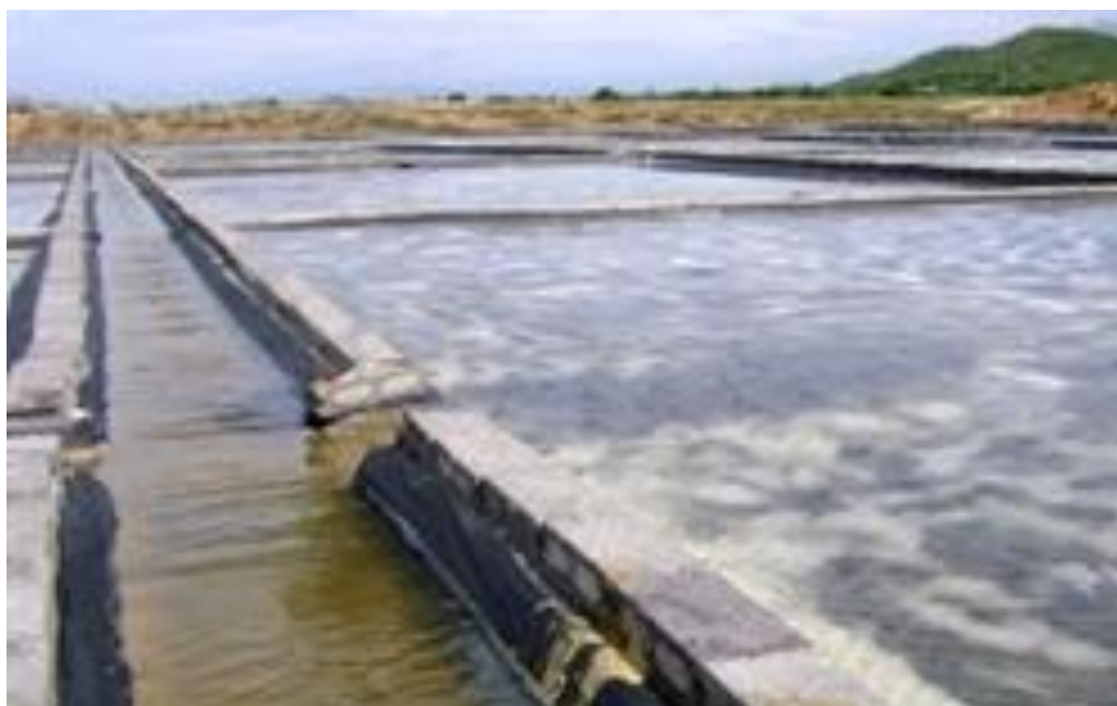
Hình 3.8: Mở phai để nước chạt bão hòa vào ô kết tinh muối đủ chiều sâu nước đã định mới đóng phai
