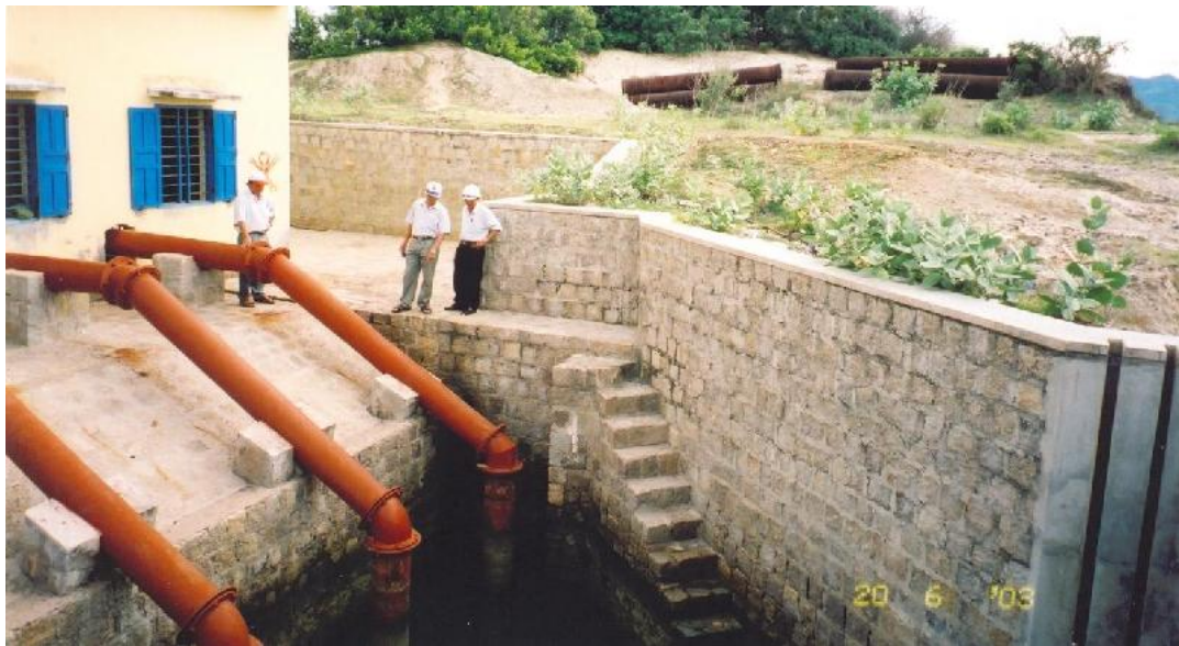
Hình 1.2: Lấy nước biển kết hợp giữa tự lưu và động lực
