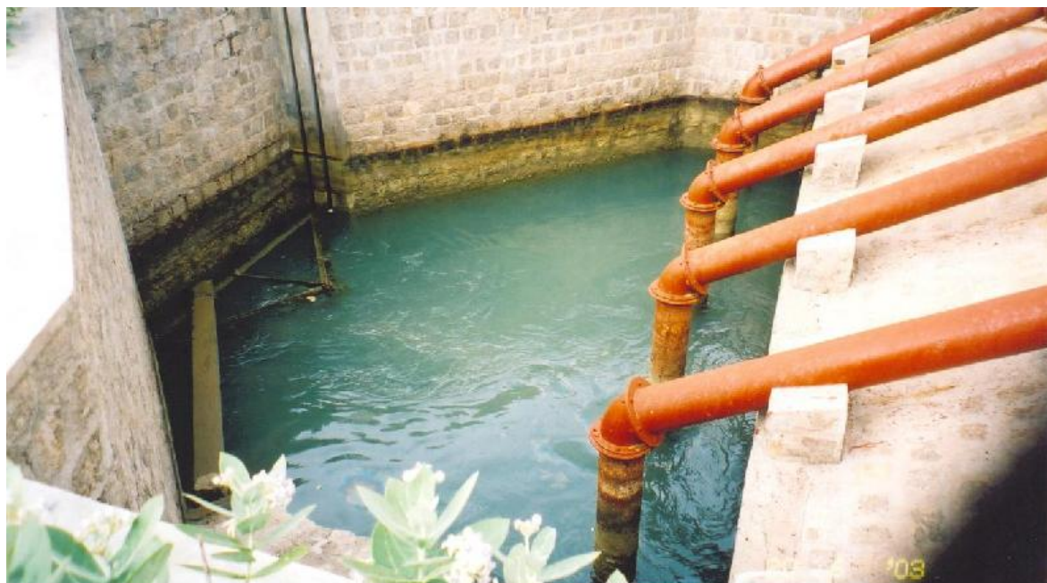
Hình 1.3: Lấy nước biển kết hợp giữa tự lưu và động lực
