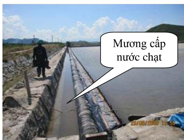
Hình 1.15: Mương cấp nước chạt cho ô kết tinh muối
